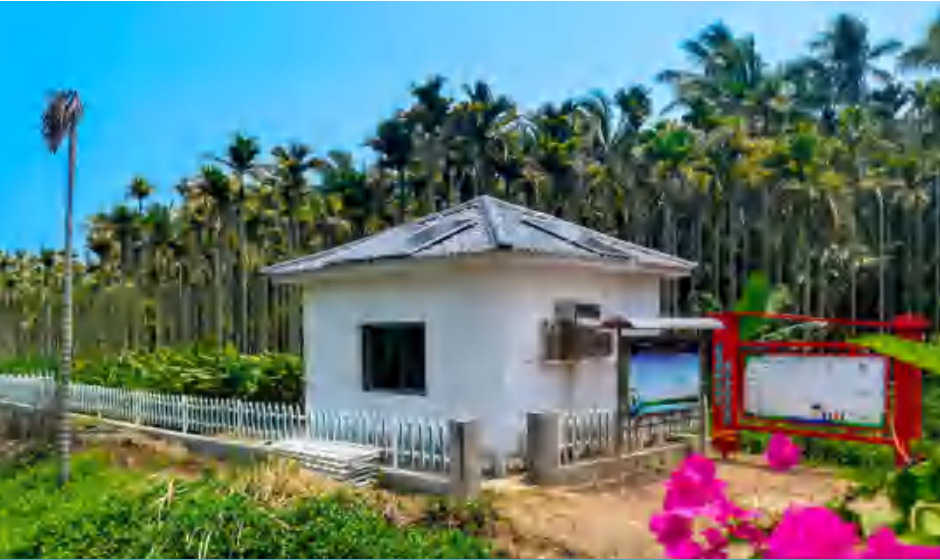
海南博鳌镇“美丽乡村”污水处理智慧管理示范项目
