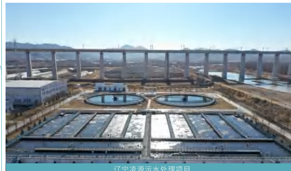
辽宁凌源污水处理项目
